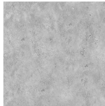
BETONILHA AFAGADA COM HELICÓPTERO
